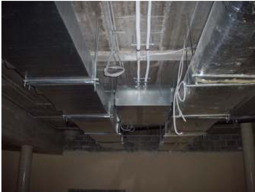
Installation sans faux-plafonds
