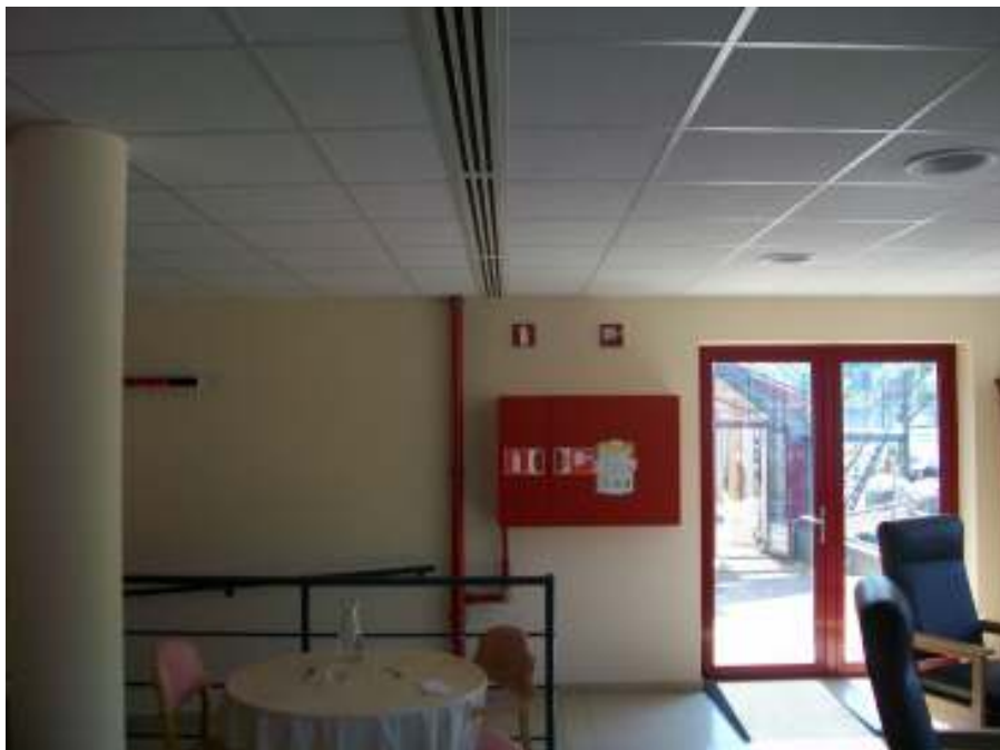
Installation avec les faux plafonds installés et grilles linéaires
